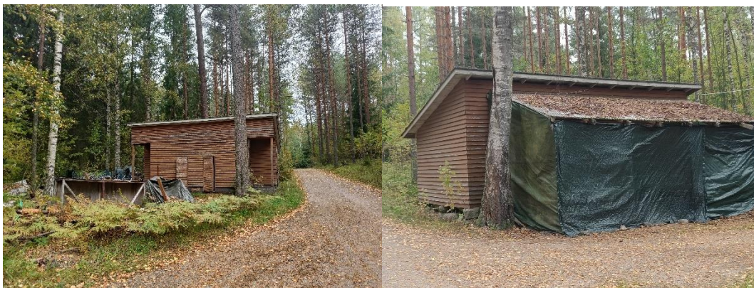
Eteläisemmän parakin ulkorakennukset
