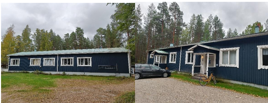
Pohjoisempi parakki (talvimajoitus) Etu- ja takajulkisivu kuvattuna.
